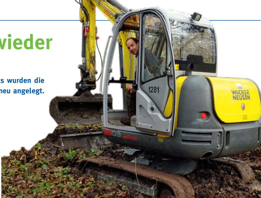
Einsatz in schwierigem Gelände: Der Kleinbagger drohte im schlammigen Untergrund zu versinken.
